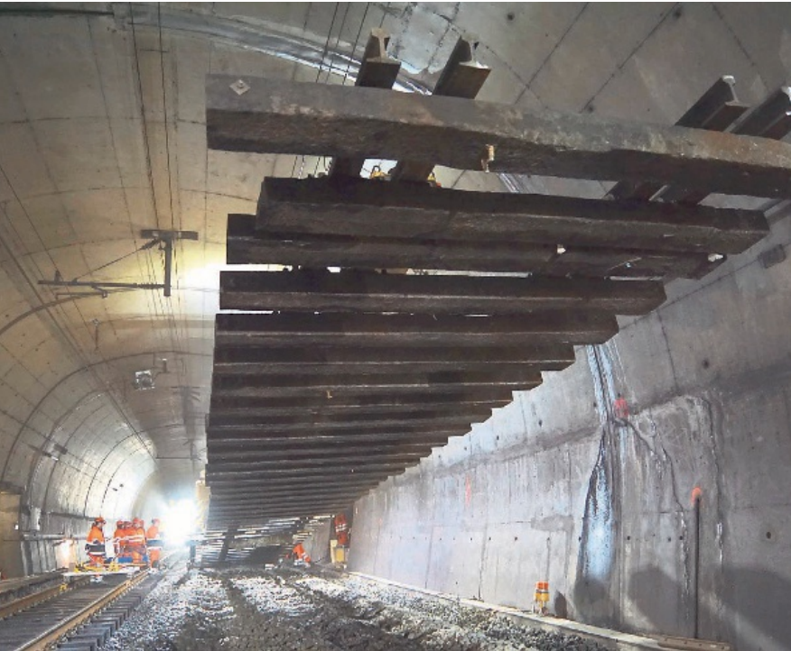
Der Gleiskran hebt die tonnenschwere Weiche am Stück aus ihrem Schotterbett. BILDER ROGER SUTER
