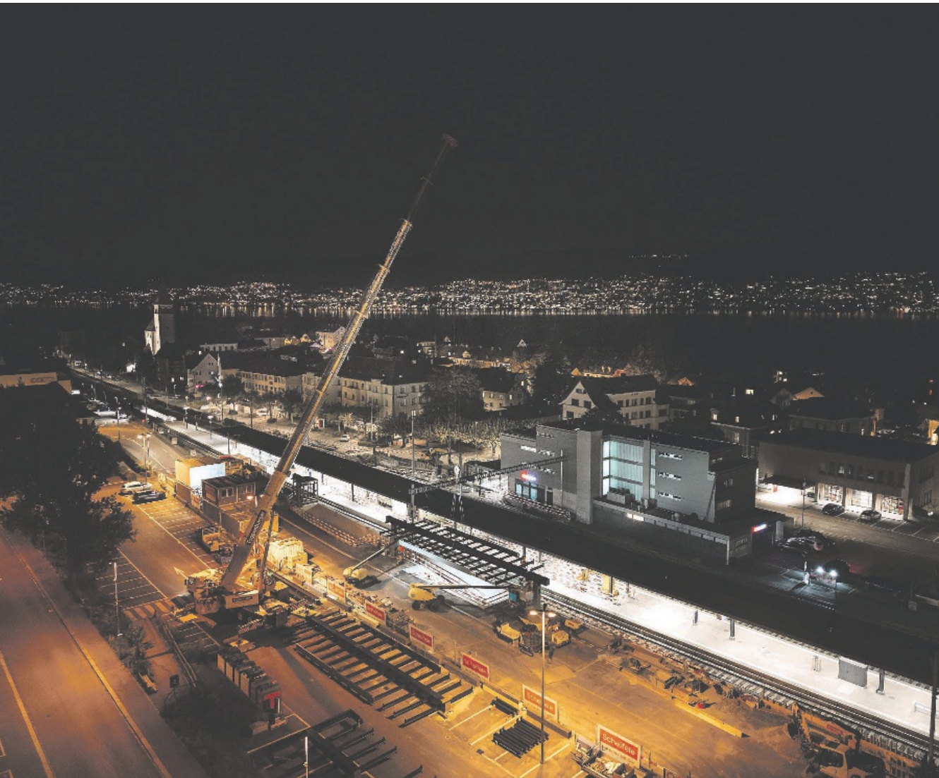
Bergseitig gibt es ein neues Perrondach: Die Anlieferung der 63 Meter langen Konstruktion geschah mittels eines Krans. BILD MICHAEL KELLER PHOTOGRAPHY
