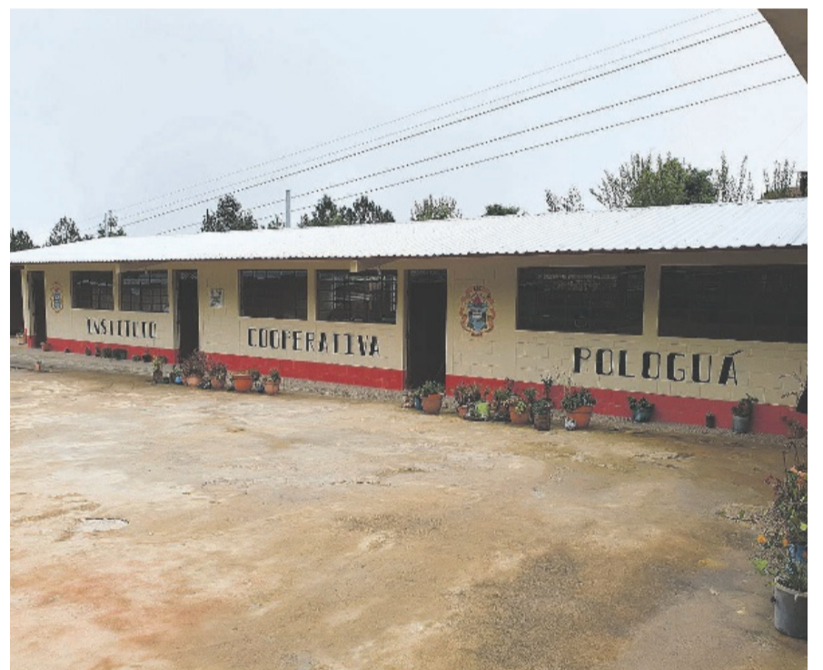
Die neu erbaute Schule Pologuá. Für dieses Jahr sind zwei neue Schulhäuser geplant.
