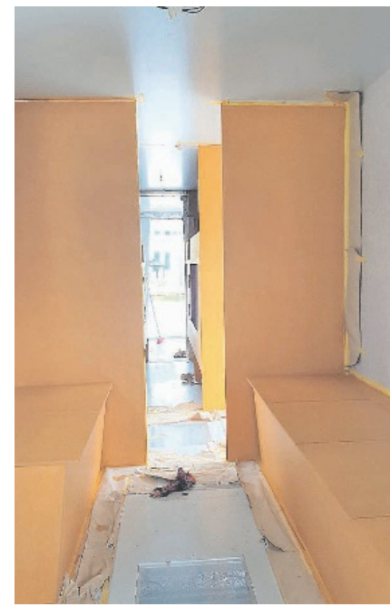
Momentan im Umbau: das Innere des Wagens.
