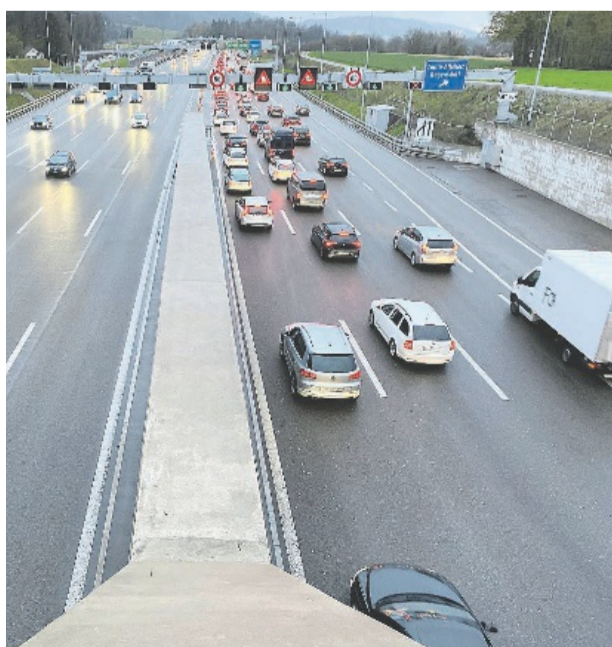
Die Sicht vom Autobahndeckel Affoltern in Richtung Weiningen.
