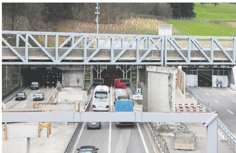
Die drei Tunnelportale Gubrist-Nord mit dem neuen Drei-Spur-Eingang ganz rechts.
