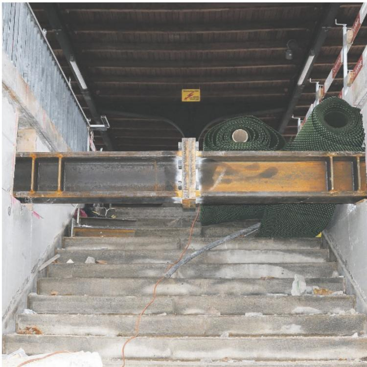
So sieht die massive Verstrebung zur Befestigung der Perronhilfsbrücke aus.
