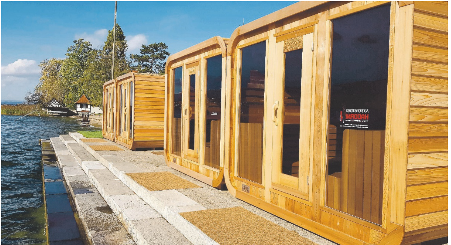
Herrliche Seelage: Im Strandbad Küsnacht lässt es sich in den vier Saunacubes bei bester Aussicht entspannen. Anschliessend bietet der See die nötige Abkühlung.
